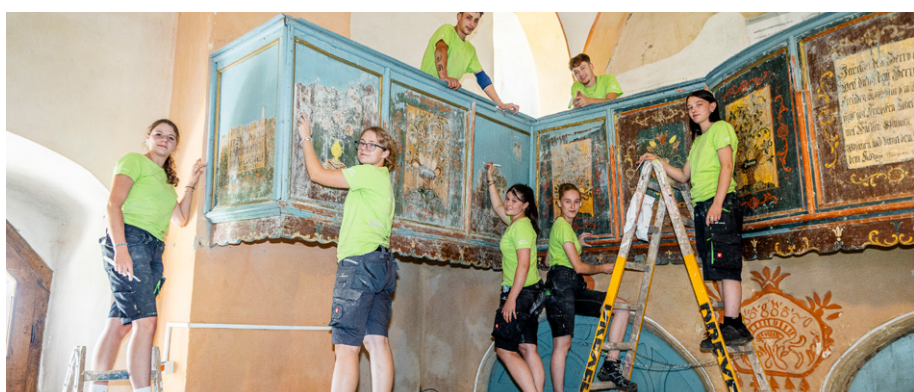
Freilegung in einer Kirche
